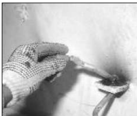
Figura 5. Anclas con casquillos plásticos.
