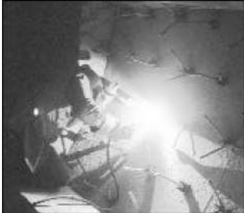
Figura 7. Soldadura de anclajes.
