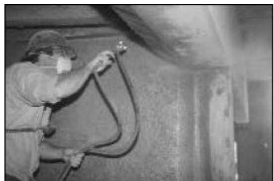
Figura 13. Rociado de componente para fraguar.
