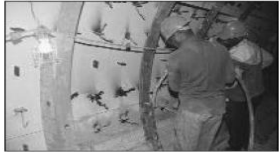
Figura 7. Vibrando detrás de las formas.
